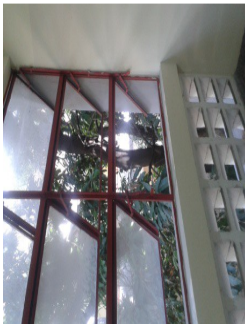
Gráfico 18. Ventanas sin protección, propensa a tener vidrios rotos que caen al patio central en la U.E.N. Gustavo Herrera
