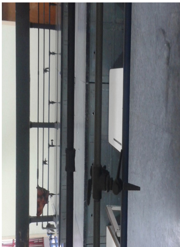
Gráfico 7. Laboratorio de química donde no se distinguen la codificación de tuberías.
