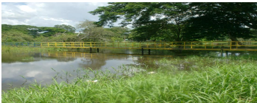
Pasarela del lado izquierdo que conforma el puente principal.
