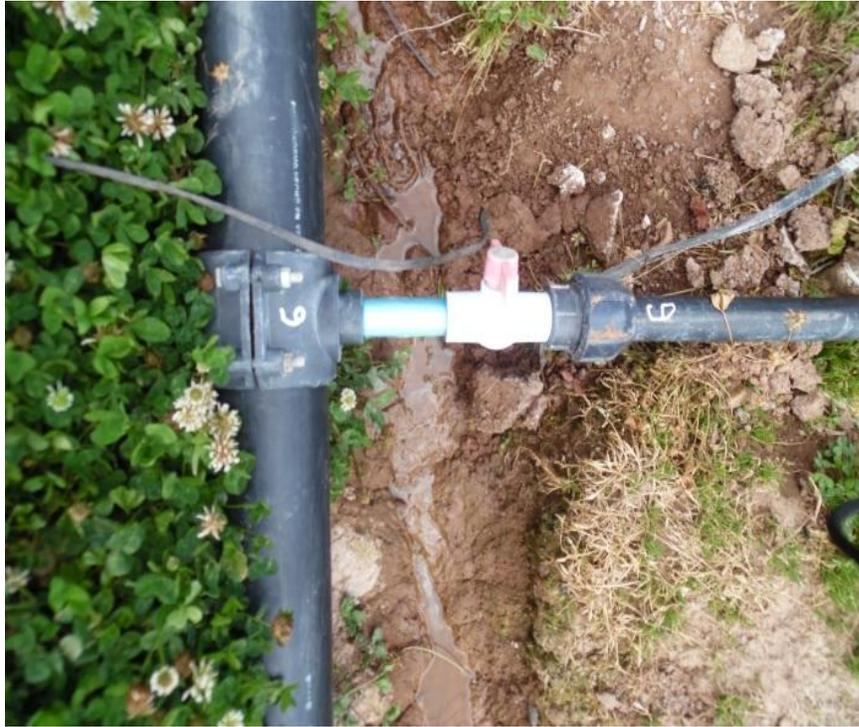
**Figura 16.** Fotografía que representa la calidad de la instalación de la toma de riego de la tubería principal, para su distribución al cultivo del productor Pedro.
